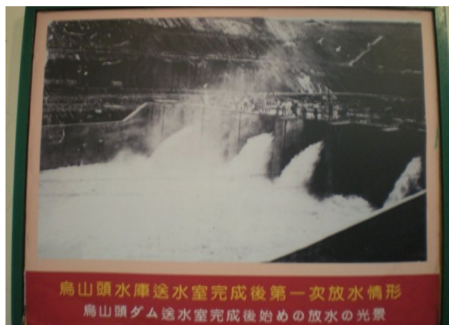
送水室完成後の第一次放水の様子
