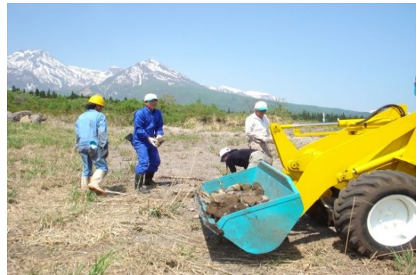
土の中の石を取り除いていきます
